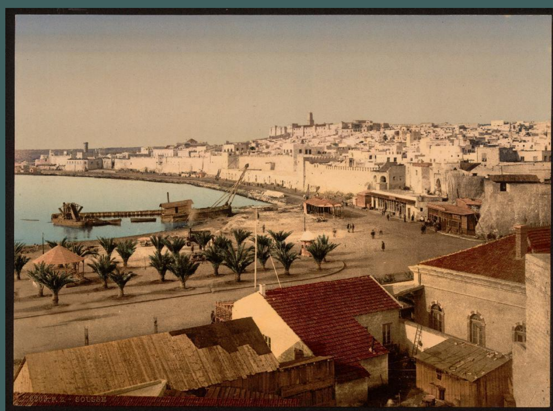
Ci-dessus : Photo du siècle précédent, figurant Sousse, centre maritime et commercial important port maritime et ville commerciale, telle qu'elle était il y a 100 ans (Image : Bibliothèque du Congrès).
