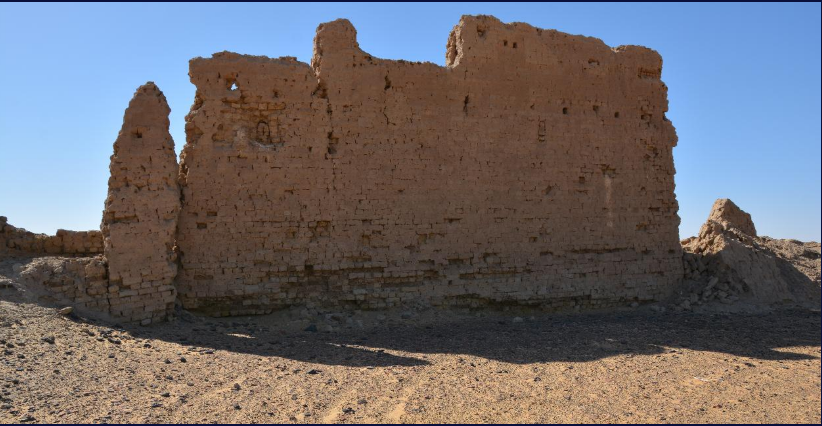
بالأسفل: دير الشيخ مفتاح، تسببت الرياح القوية في حدوث شروخ في الجدران المبنية من الطوب اللبن. الواحات الداخلية (صورة: محمد قناوي).
